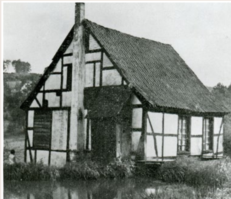
WÜSTHOF's erster Kotten im Weinsbergtal WÜSTHOF's "Kotten" in the "Weinsbergtal"
